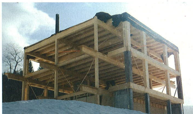
SKELET NAD ŠPINDLEM stojí na místě typické krkonošské chalupy. Stane se součástí rozlehlé vily zapuštěné do svahu. Vlastní ji hradecký podnikatel spojovaný s pražským kmotrem Romanem Janouškem.
