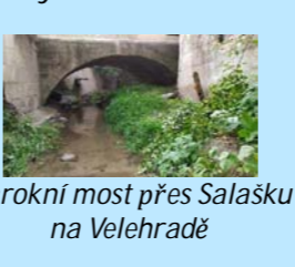
Barokní most přes Salašku na Velehradě
