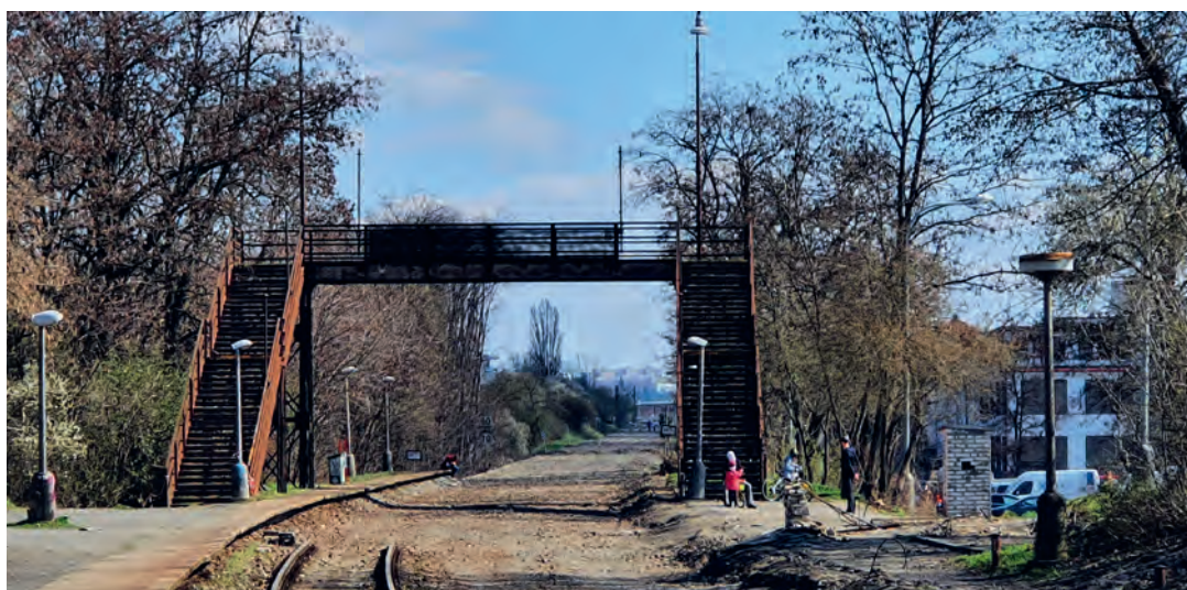
Obr. 3 Také městská železniční krajina prochází v současné době významnými změnami. Při přestavbě pražského dopravního uzlu došlo k přeložení trati mezi Vršovicemi a Hostivaří. Zanikla tak zastávka Praha-Strašnice s ikonickou železnou lávkou. Železniční násep se v blízké budoucnosti má přeměnit na stezku pro cyklisty a jeho okolí na liniový park, vzorem pro něj je známá High Line v New Yorku. Foto: Dana Fialová.
