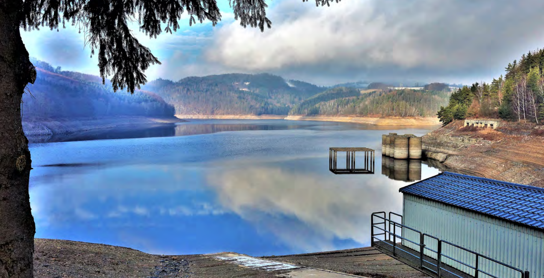
Obr. 6.5.1.3 – Při nízkém stavu vody vystupují z vody mohutné betonové skruže a další zbytky konstrukce bývalé betonárky, která míchala beton na stavbu gravitační betonové hráze Vírské přehrady. Foto Z. Lipský.
