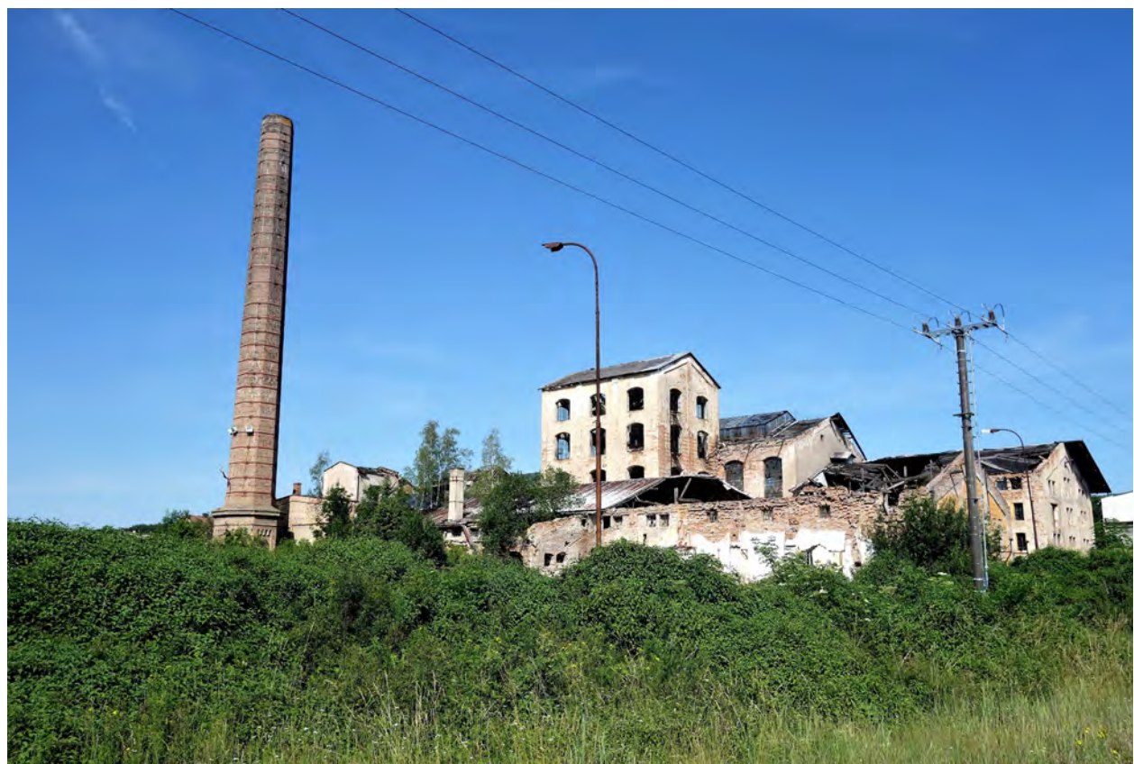
Obr. 6.3.1.8 – Ruiny cukrovaru v Dymokurech symbolizují někdejší slávu a současný pád českého cukrovarnictví. Cukrovar byl uveden do provozu v roce 1870, pro usnadnění svozu cukrové řepy byla vybudována řepařská drážka v celkové délce 30 km. Provoz cukrovaru byl ukončen v roce 1991, od té doby beznadějně chátrá. Foto Z. Lipský.
