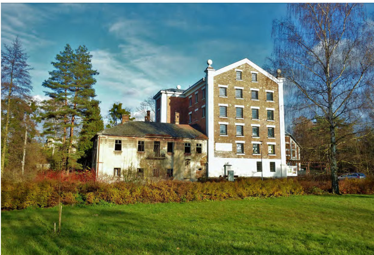
Obr. 6.1.2.11 – Bývalý Janečkův mlýn v Karviné-Darkově. Budova, nad níž i památkáři „zlomili hůl“ a která byla odsouzena k zániku, se stala po úspěšné rekonstrukci v roce 2015 sídlem Slezského vzdělávacího centra. Foto Z. Lipský.
