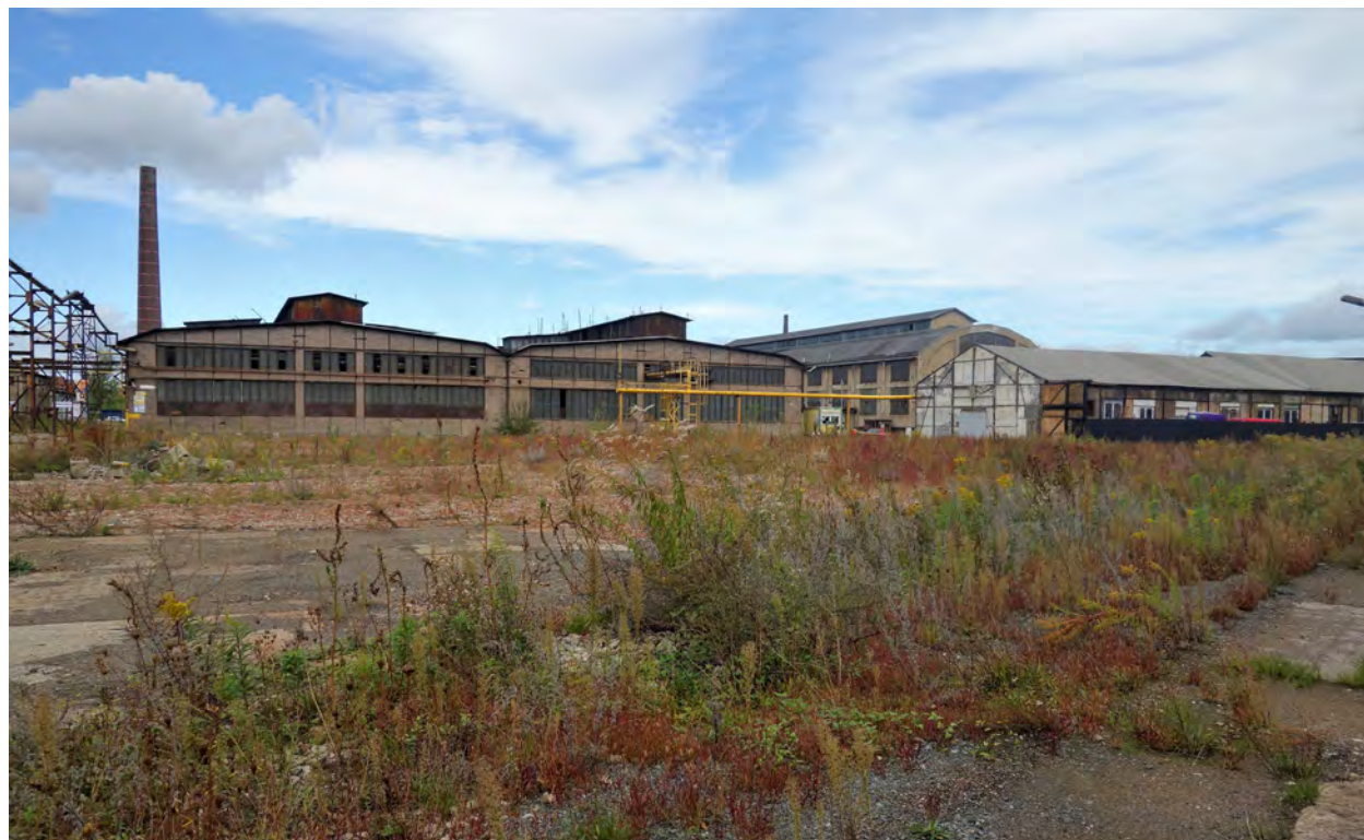
Obr. 6.2.1.2 – Podstatnou část někdejšího průmyslového areálu SONP Kladno v současnosti představuje charakteristický brownfield. Foto Z. Lipský.
