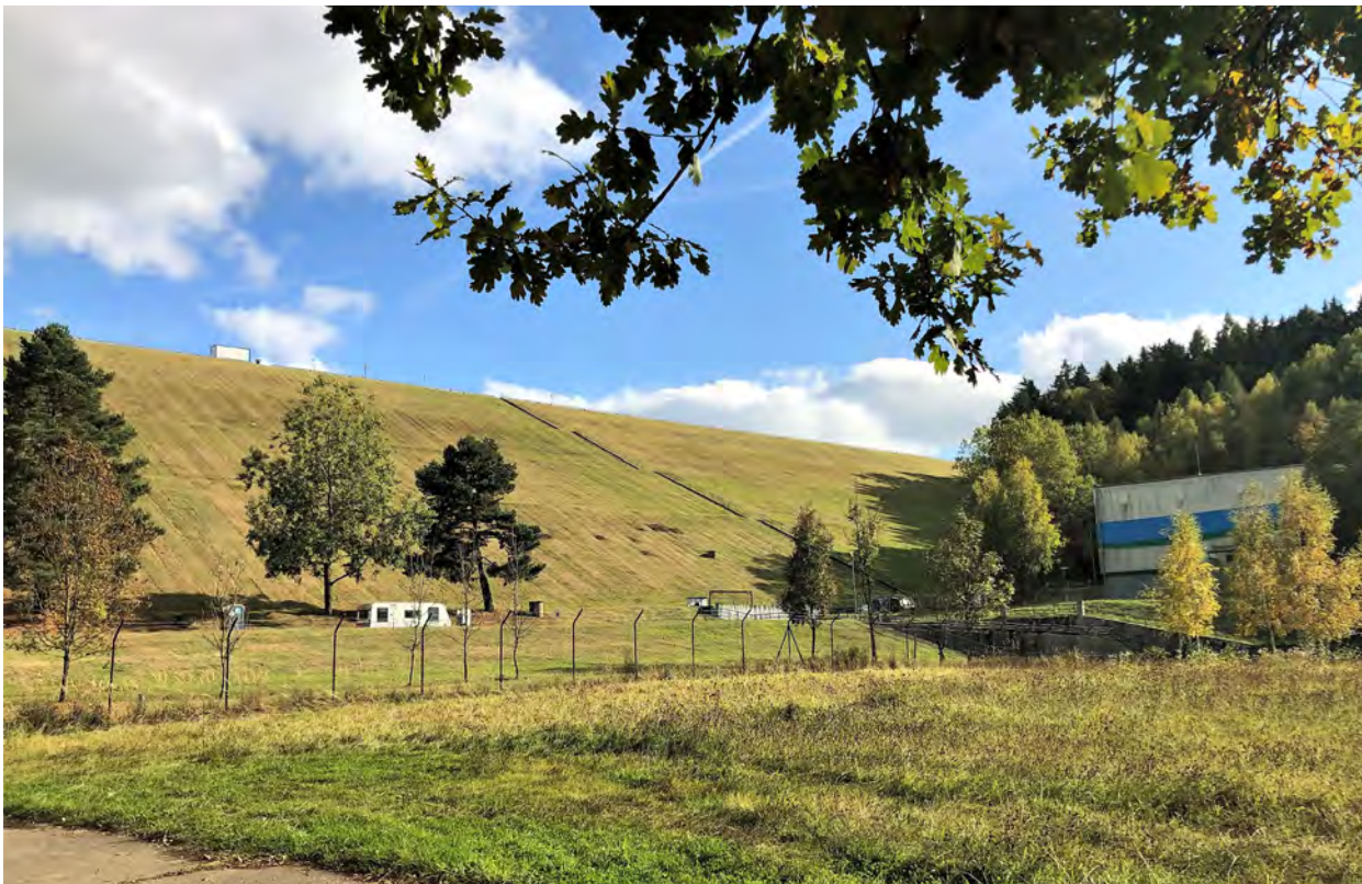
Obr. 6.5.2.7 – Mohutná zemní hráz vodárenské nádrže Švihov vysoká 58 m a dlouhá 860 m přehradila Želivku jižně od Zruče nad Sázavou v říčním kilometru 4,29. Foto M. Čábelka.
