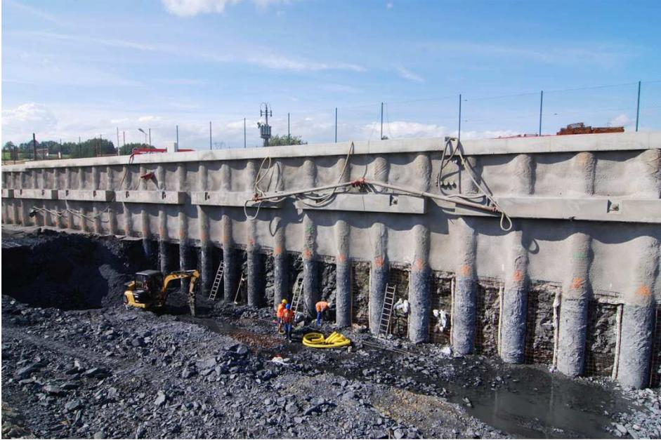
Fig. 15. Pile wall
