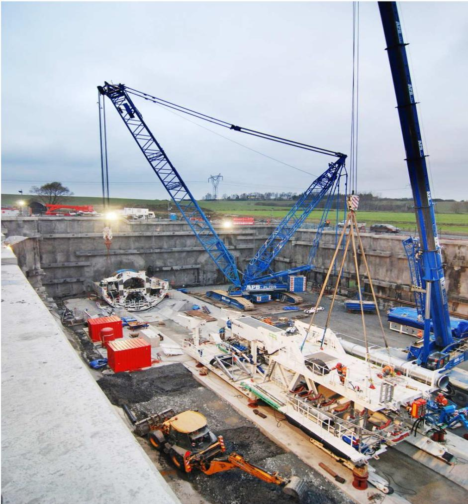
Fig. 16. TBM assembly
