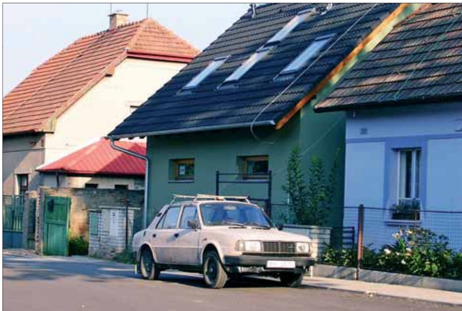
Obr. 8.8 Starší zástavba Zelenče. Foto P. Puldová.
