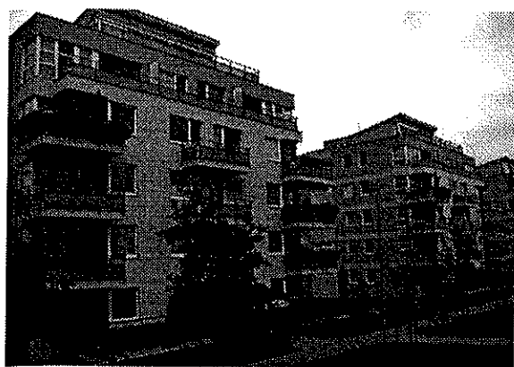
Abb. 7: Neue Kondominien in Prag / Černý Most (Autor)
