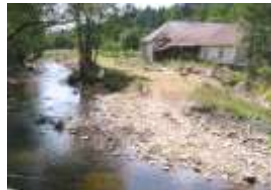
5. Budovy v nivě
