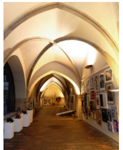
pohled do křížové chodby
