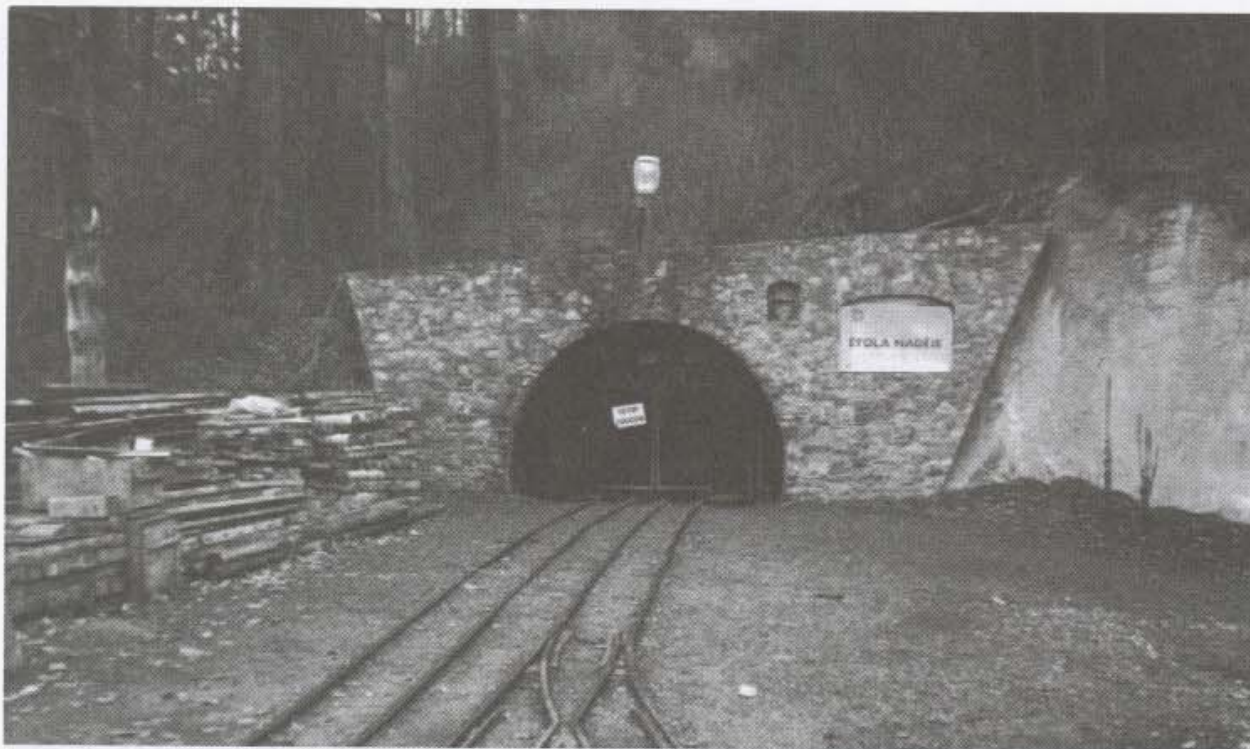
Photo 3: Entry to the Naděje gallery on the right bank of the Zlatý potok Brook Foto 3: Vchod do štoly Naděje na pravém břehu Zlatého potoka
