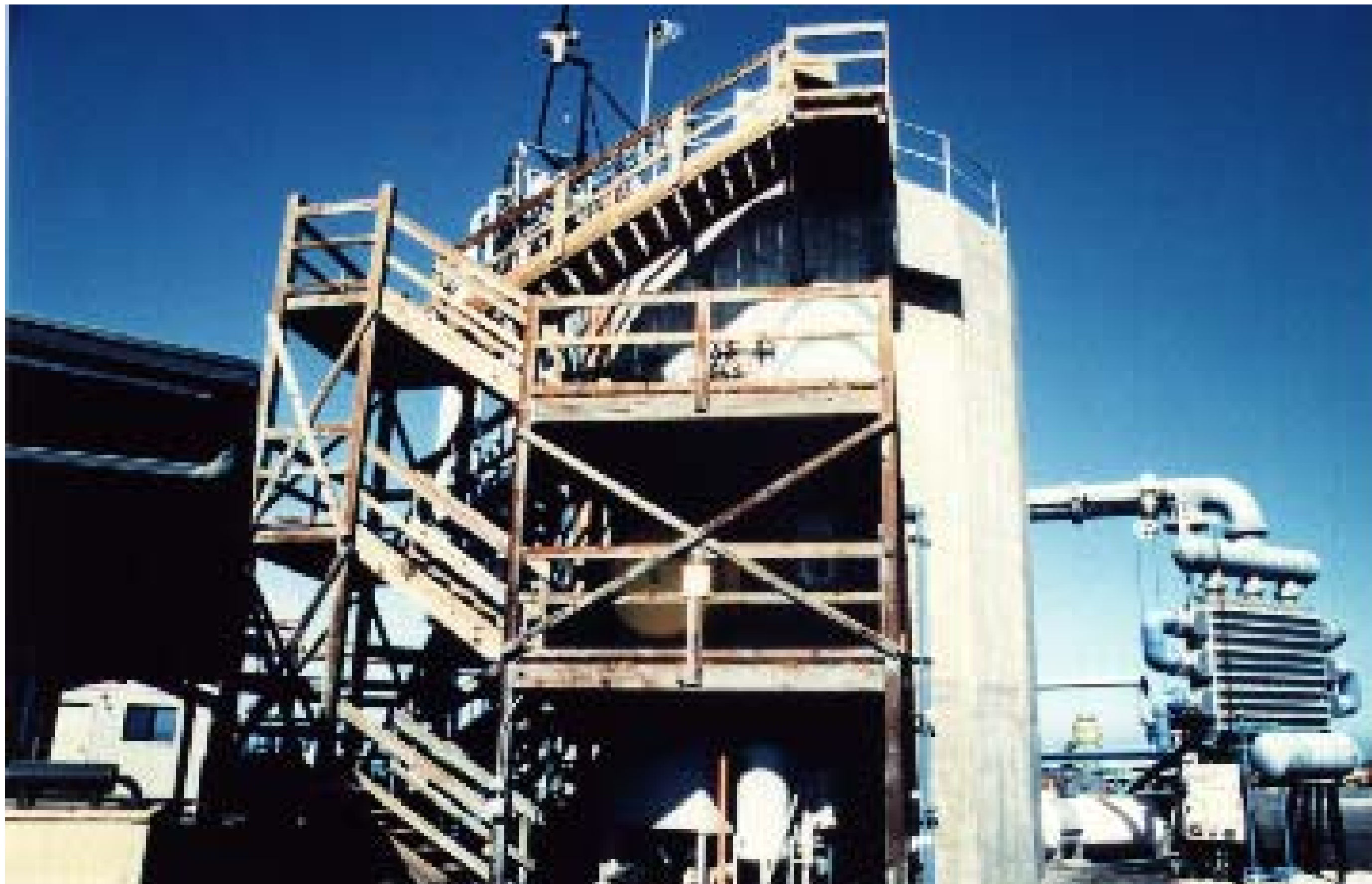
OTEC – otevřený cyklus, Havai, NELHA (1992-1999; 210kWe)
