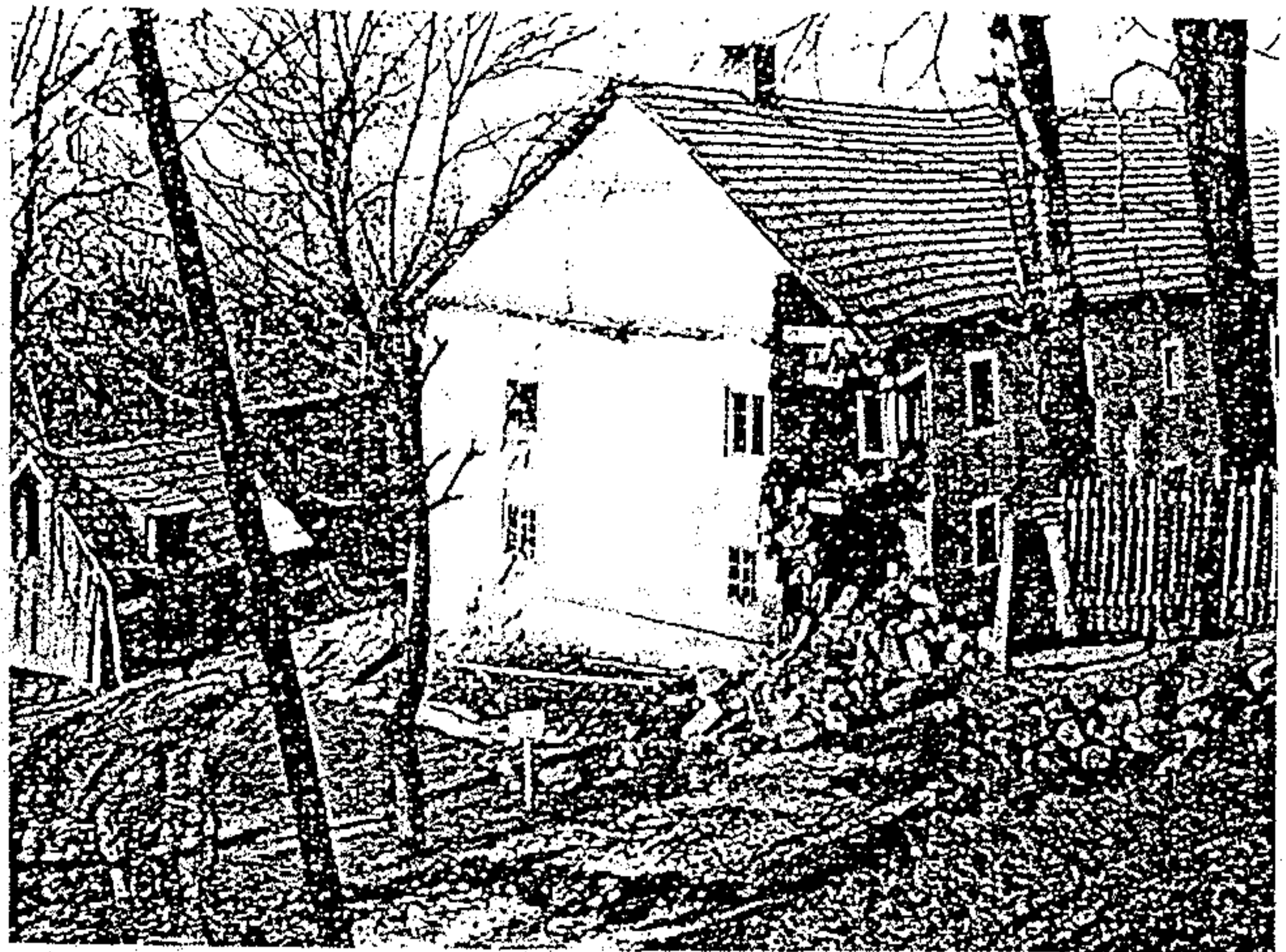
Obr. 15.14. Stavení zničená sesuvem u Handlové v r. 1961 (foto Q. Záruba)
