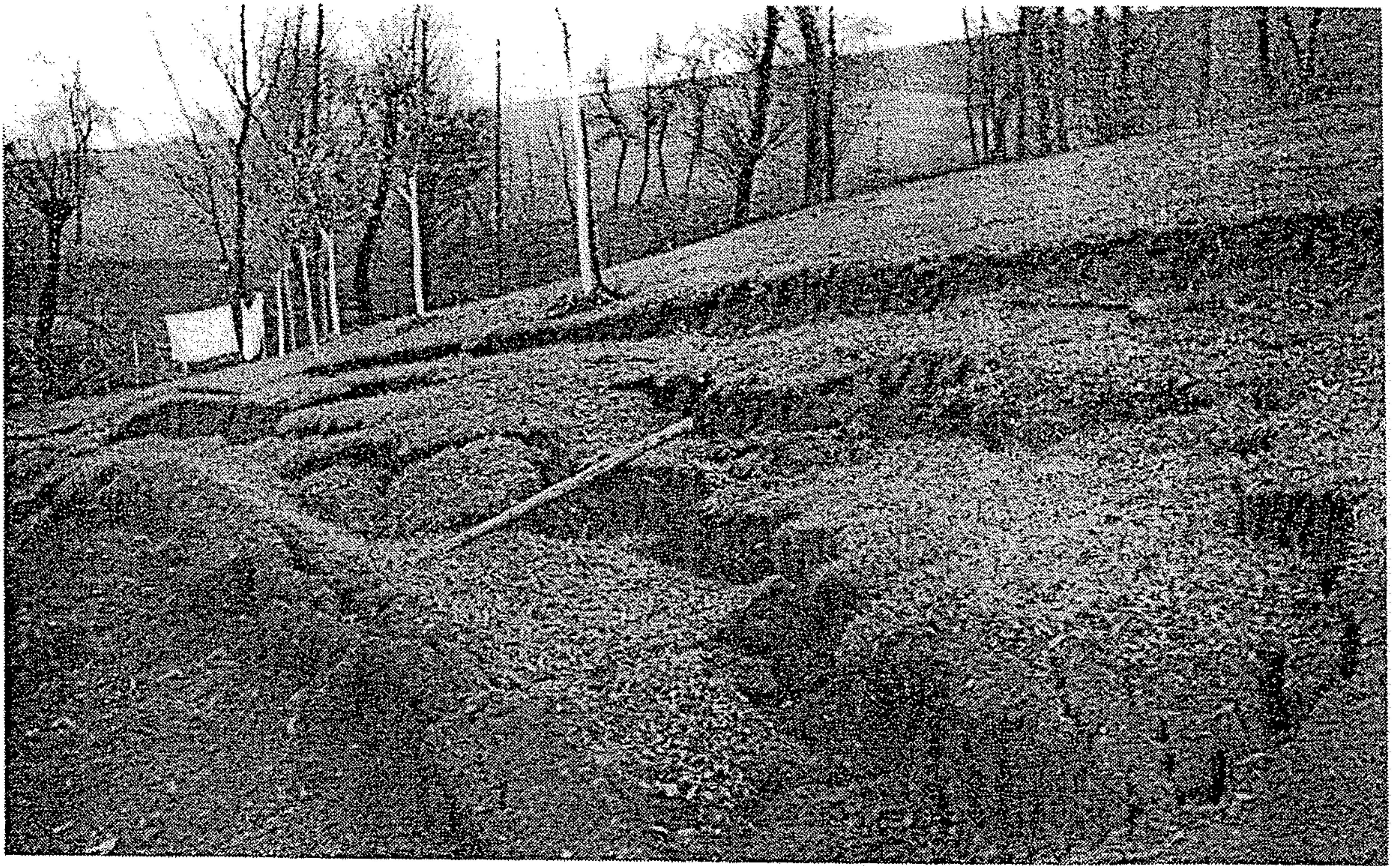
Abb. 175. Abrutschender Boden , der im Ablösungsgebiet eines Rutschgebietes bei Zádveřice in Mähren in Schollen zerrissen ist. (Foto Prof. QU. ZÁRUBA.)
