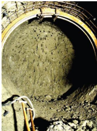
Obr. 1: Čelba nevystrojené rozrážky R2 (Pavlík et al., 2004).
