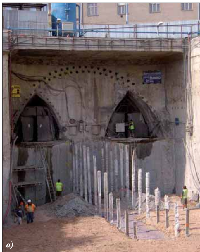
Obr. 2 Průzkumné štoly situované v kalotě tunelu (a), levá štola s hranicí zdravého a navětralého jílu (b)
