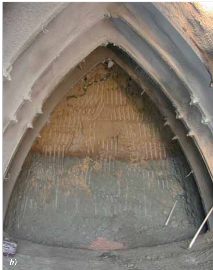
Obr. 2 Průzkumné štoly situované v kalotě tunelu (a), levá štola s hranicí zdravého a navětralého jílu (b)
