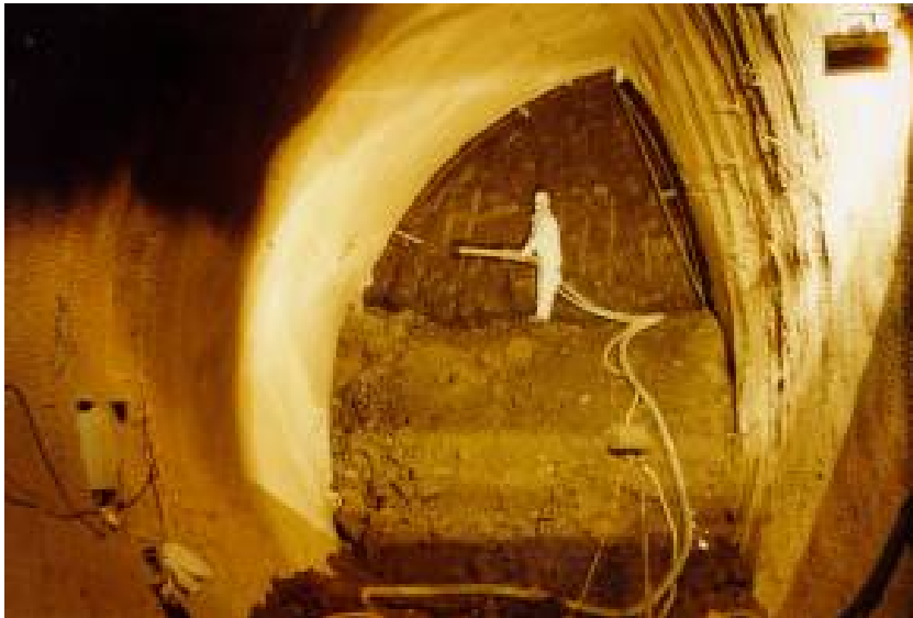
Aplikace primárního ostění
