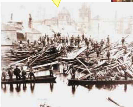
Poškozený Karlův most Letní povodeň 1890
