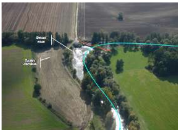
Příklad - Nevhodně situovaný jez jako potenciální překážka proudění na dolní Opavě
