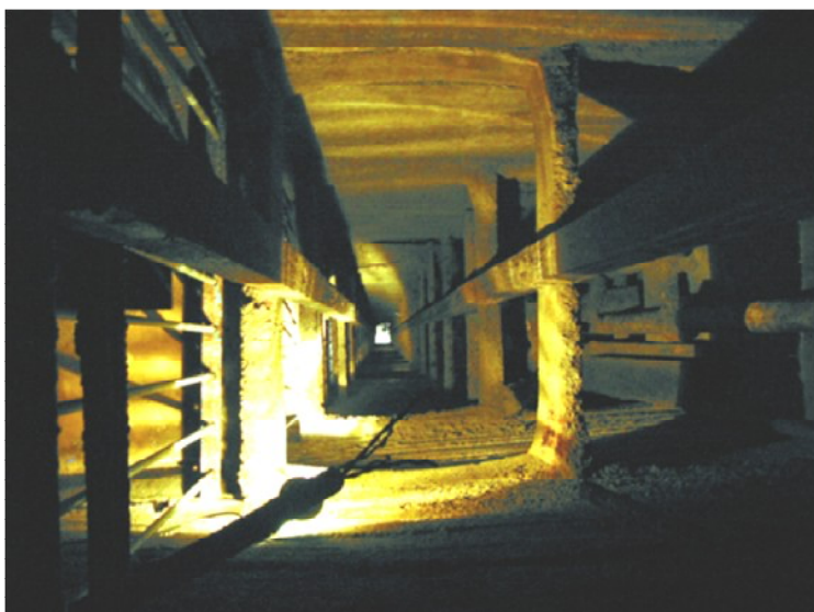
Obrázek 61 Těžební jáma příbramských dolů. Systém šachet, sahající do hloubky přes 1 km je až do úrovně 250 m pod povrchem zatopen. Díky tomu se kontaminanty – zde zejména těžké kovy a radioaktivní látky, nekontrolovaně vyplavují do systému podzemních a následně povrchových vod. Foto J. Langhammer, 2002
