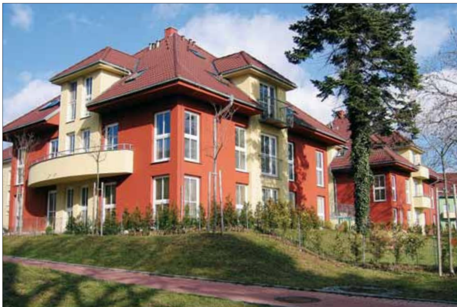
Obr. 9.2 Bytový dům v Kolovratech. Foto L. Sýkora.
